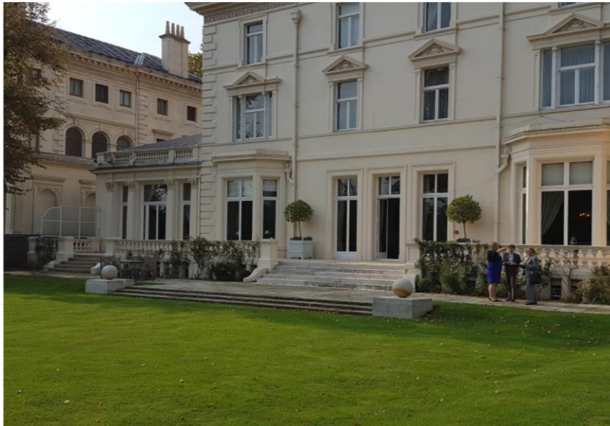
La résidence de France
